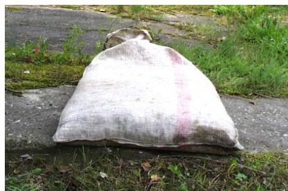
Obr.9 Správně naplněný pytel
