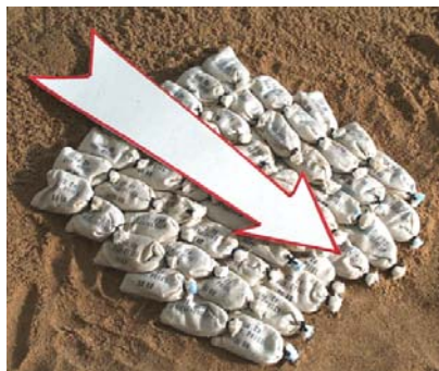
Obr. 27 a 28 Postupné překrývání otvoru
