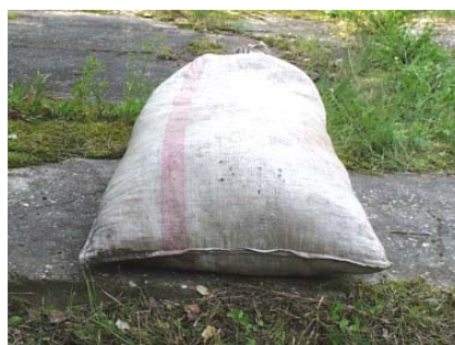
Obr.10 Příliš naplněný pytel
