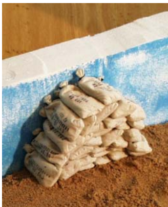
Obr. 24 Otvor zakrytý příložným utěsněním
