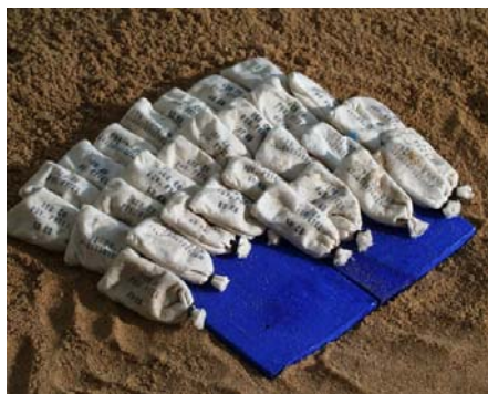
Obr. 27 a 28 Postupné překrývání otvoru
